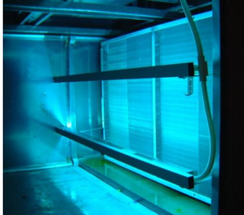
La acción germicida debe ser suficiente en toda la superficie de la batería, por lo que la radiación debe ser controlada en los lugares más alejados del emisor.
